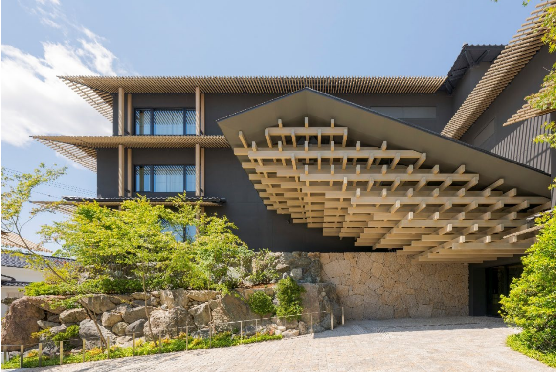
2024年8月20日グランドオープン「バンヤンツリー・東山 京都」エントランス外観
